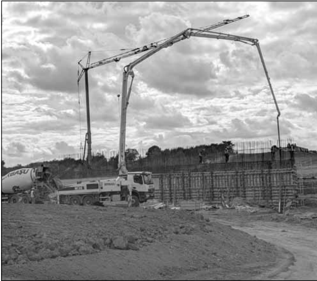
A3. Stadiul lucrărilor pe lotul Suplacu de Barcău – Chiribiș
