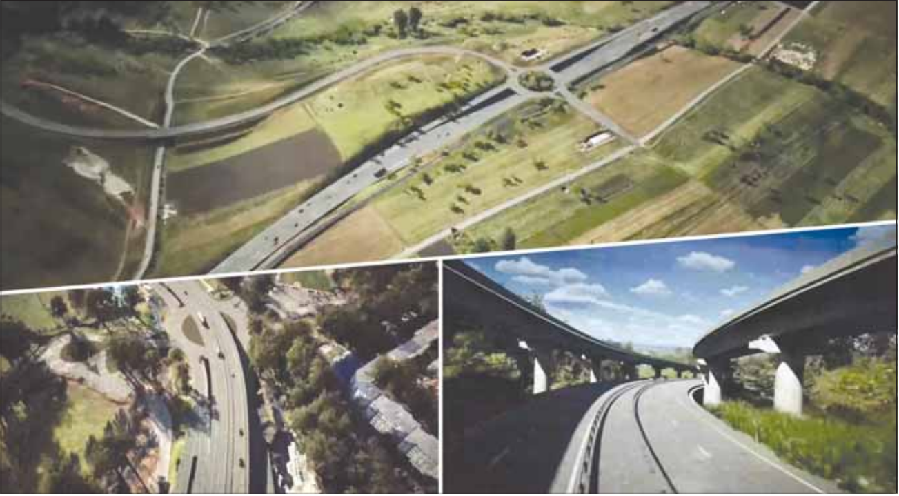
Primarul Clujului Emil Boc a anunțat, vineri, debutul lucrărilor de proiectare și a procedurilor de expropriere la tronsonul doi al centurii metropolitane
