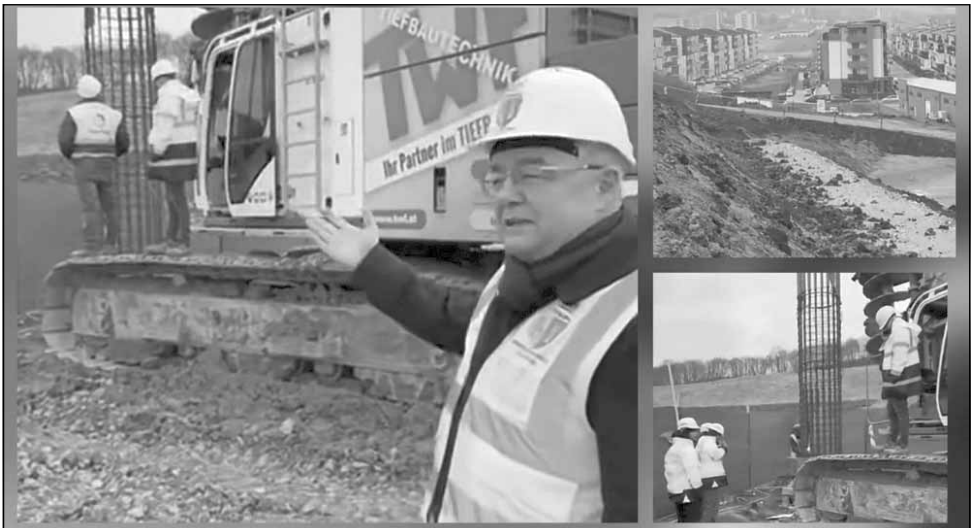
În luna martie, primarul Emil Boc spunea că ploile au întârziat lucrările la pilotii forati de la metroul din Cluj
