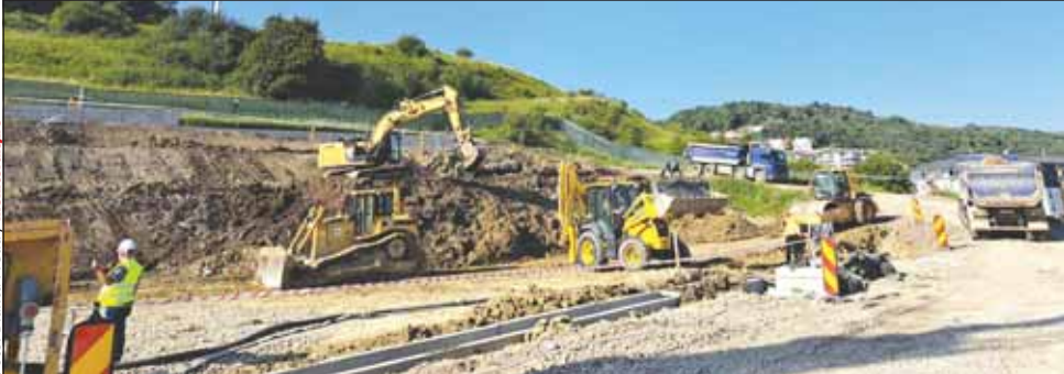
Zeci de utilaje și muncitori lucrează la puțul de lansare, amplasat în zona stației Teilor (stația 2), în comuna Florești
