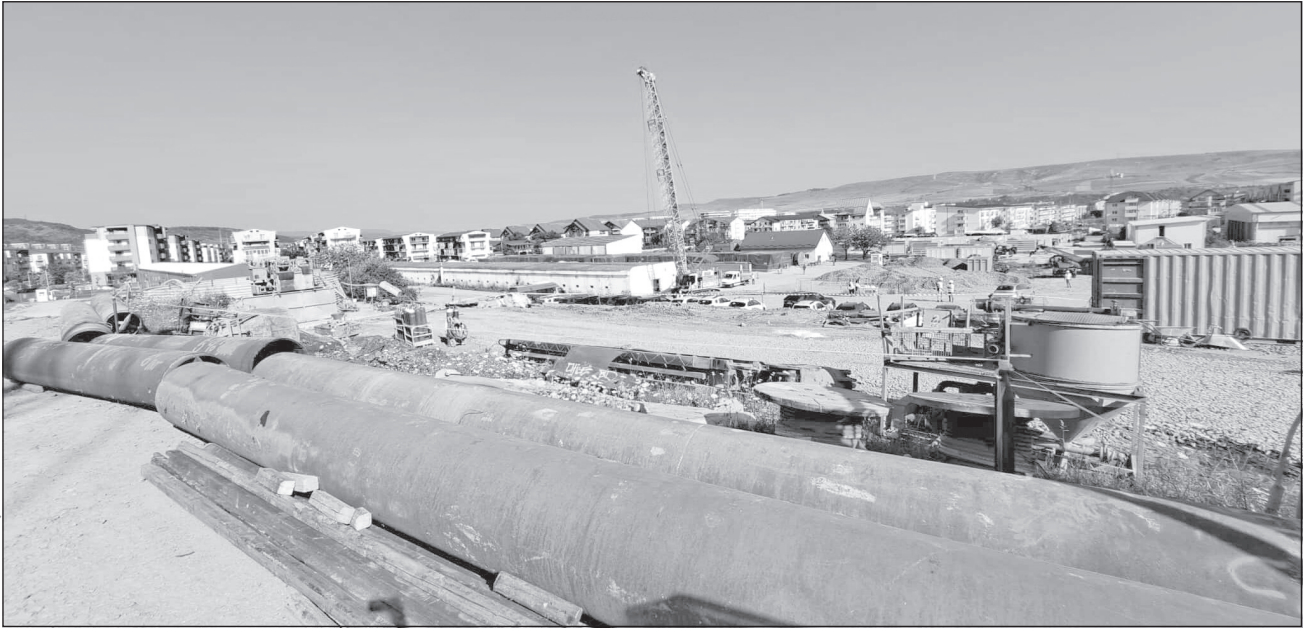
Lucrările pe șantierul metroului din Cluj
