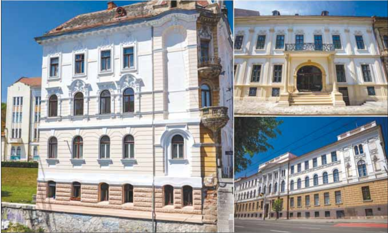
Fațadele clădirilor din centru istoric al Clujului au fost revitalizate
