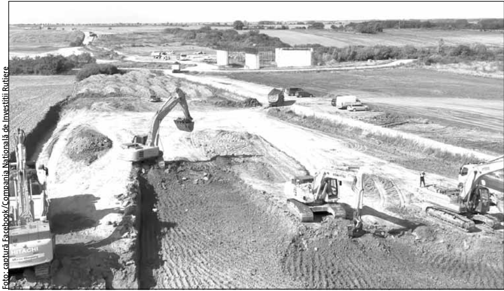
CNIR autorizează lucrările pe ultimii 20 de kilometri ai lotului de autostradă Chiribiș – Biharia
