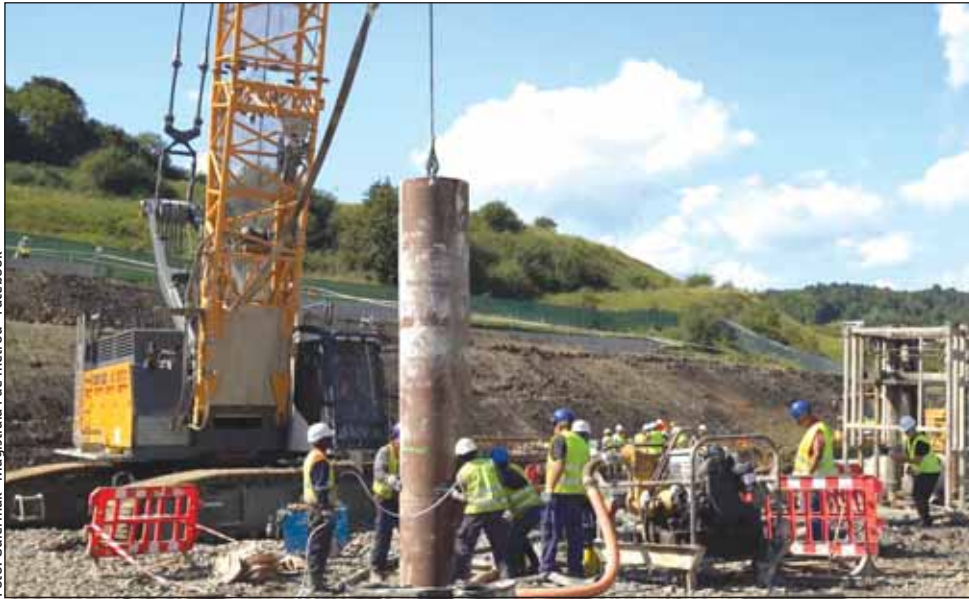
Lucrările la construcția puțului de lansare pentru cele două mașini de forat tuneluri avansează în teren
