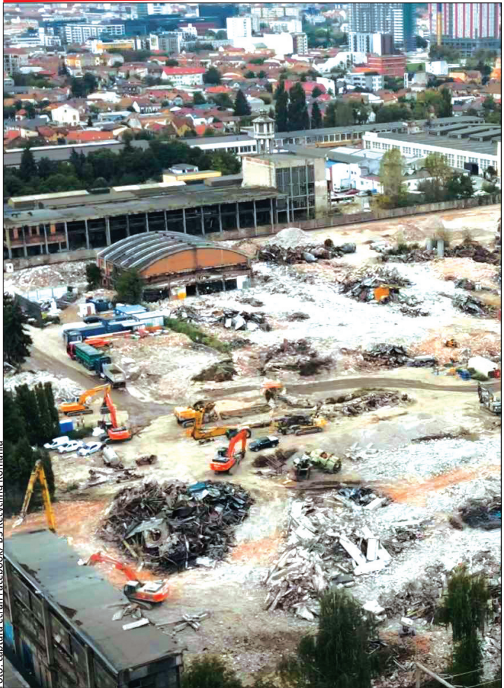
Fosta platformă industrială Carbochim a fost demolată, iar zona se va transforma radical în următorii ani printr-un amplu proiect de regenerare urbană, în valoare de peste jumătate de miliard de euro.
