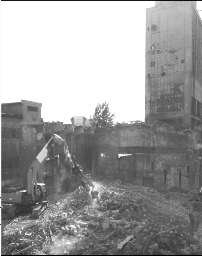
Fosta platformă industrială Carbochim din Cluj-Napoca a fost demolată
