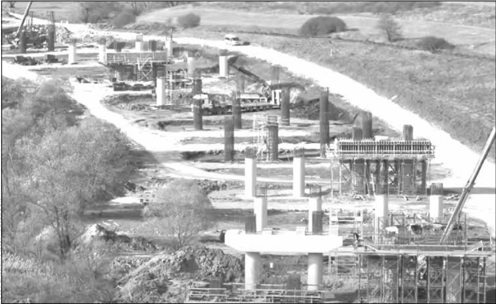
Autostrada Transilvania. Stadiul fizic pe cele două viaducte de pe secțiunea Nădășelu – Mihăiești a trecut de 35%
