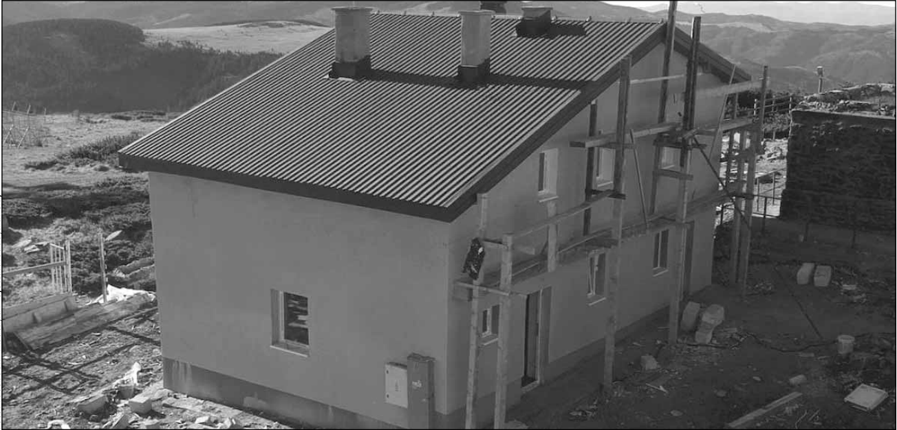
Cabana Stației Meteorologice Vlădeasa, care a ars într-un incendiu în această vară, a fost reconstruită într-un timp record
