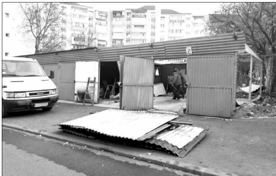
În anul 2021 l au fost create aproape 3.000 de locuri de parcare după demolarea garajelor de tablă
